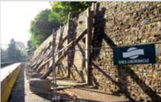
Mise en sécurité par bois ronds du mur de soutènement sur l'Avenue du 25ème RTS à Lyon.
