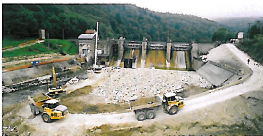
Soulce-Cernay (25) : renforcement aval du barrage EDF de Grosbois, radier, perrés et fosse de dissipation.
