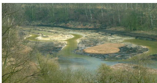
Terrassement et aménagement d'une roselière Roost-Warendin (59)
